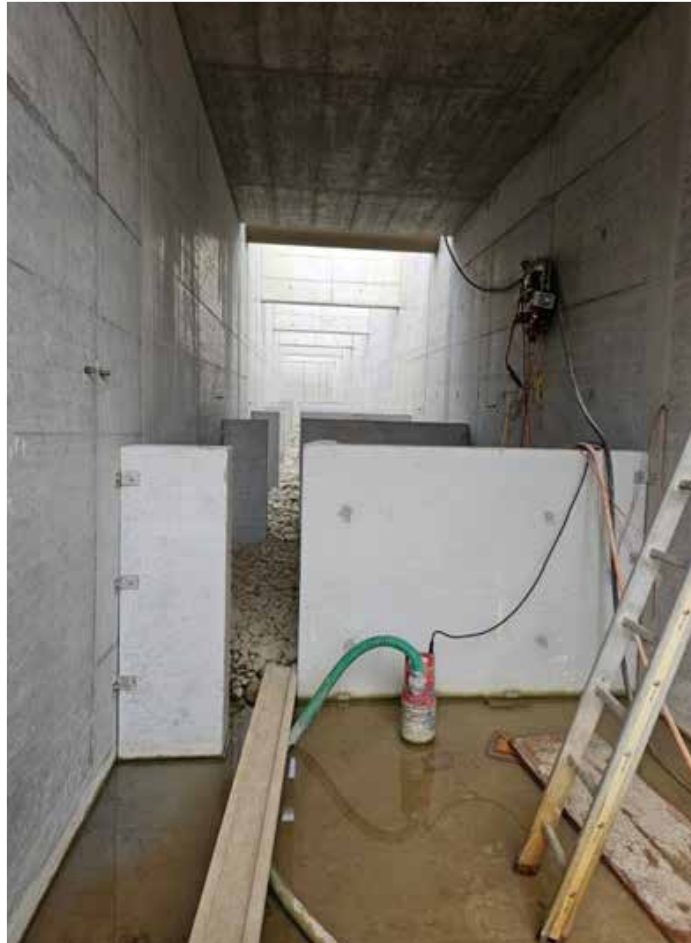
Fischpass Bannwil im Bau – Querelemente und eingebrachtes Sohlsubstrat (Quelle: Fischereiinspektorat)
