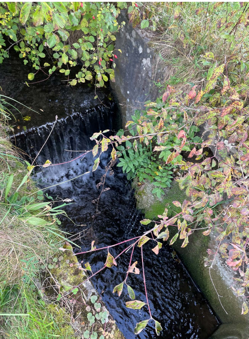
Schwelle, die mit einer Krebssperre ausgestattet wurde Seuil équipé d'un barrage à écrevisses
