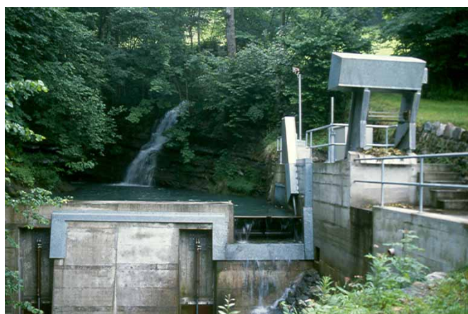
Mühlebach Hasliberg, Wasserfassung (Foto: Hans Roth)
