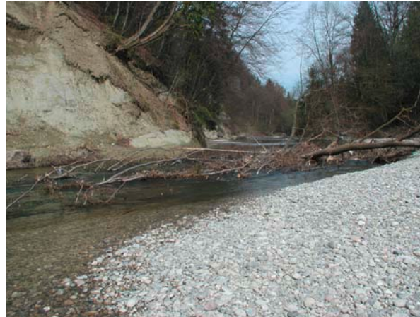
Flussaufweitung an der Emme bei Altisberg, Gemeinde Bätterkinden. Durch die Förderung von eigendynamischen Geschiebeprozessen wird der Lebensraum Fließgewässer deutlich aufgewertet. (Bild Fischereinspektorat Kt. Bern)
