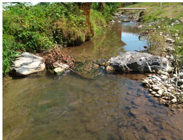
Detail Blockriegel mit abgelagertem Geschiebe (Fischlaipätze) im Scherlibach, Gemeinde Köniz. (Bild Basler und Hofmann)
