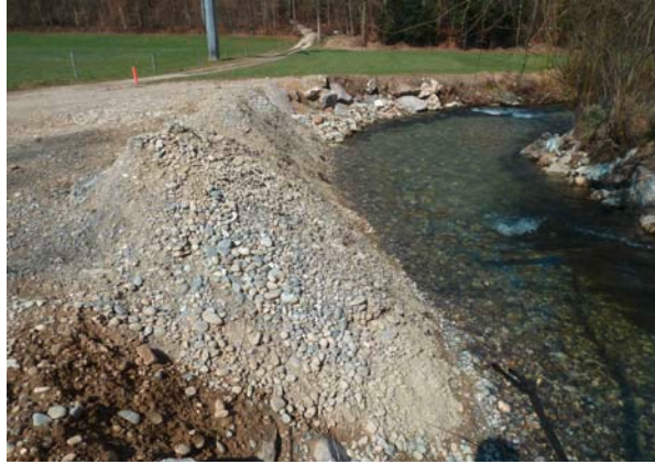
Geschieberückgabestelle Eichwald, Gemeinde Niederönz nach Fertigstellung der Bauarbeiten. Das Schüttvolumen beträgt 20m 2 . (Bild Fischereiinspektorat Kt. Bern)
