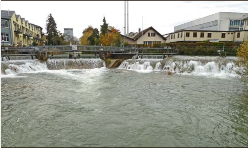
Hauserwehr in der Schüss in Biel / Barrage «Hauser» dans la Suze à Bienne
