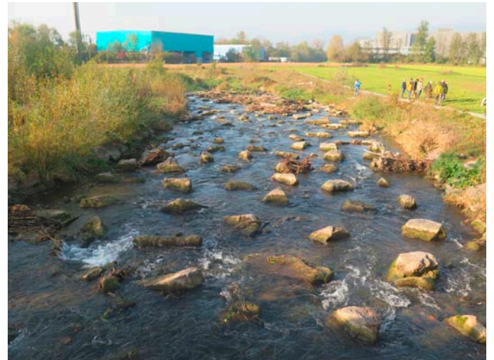
Abbildung 4 rechts: Die zirka 95 m lange Blockrampe an der Wyna bei Suhr nach Entfernung des Wehrs, Illustration 4 de droite: la rampe en enrochements d'environ 95m de long dans la Wyna à Suhr après la suppression du barrage
