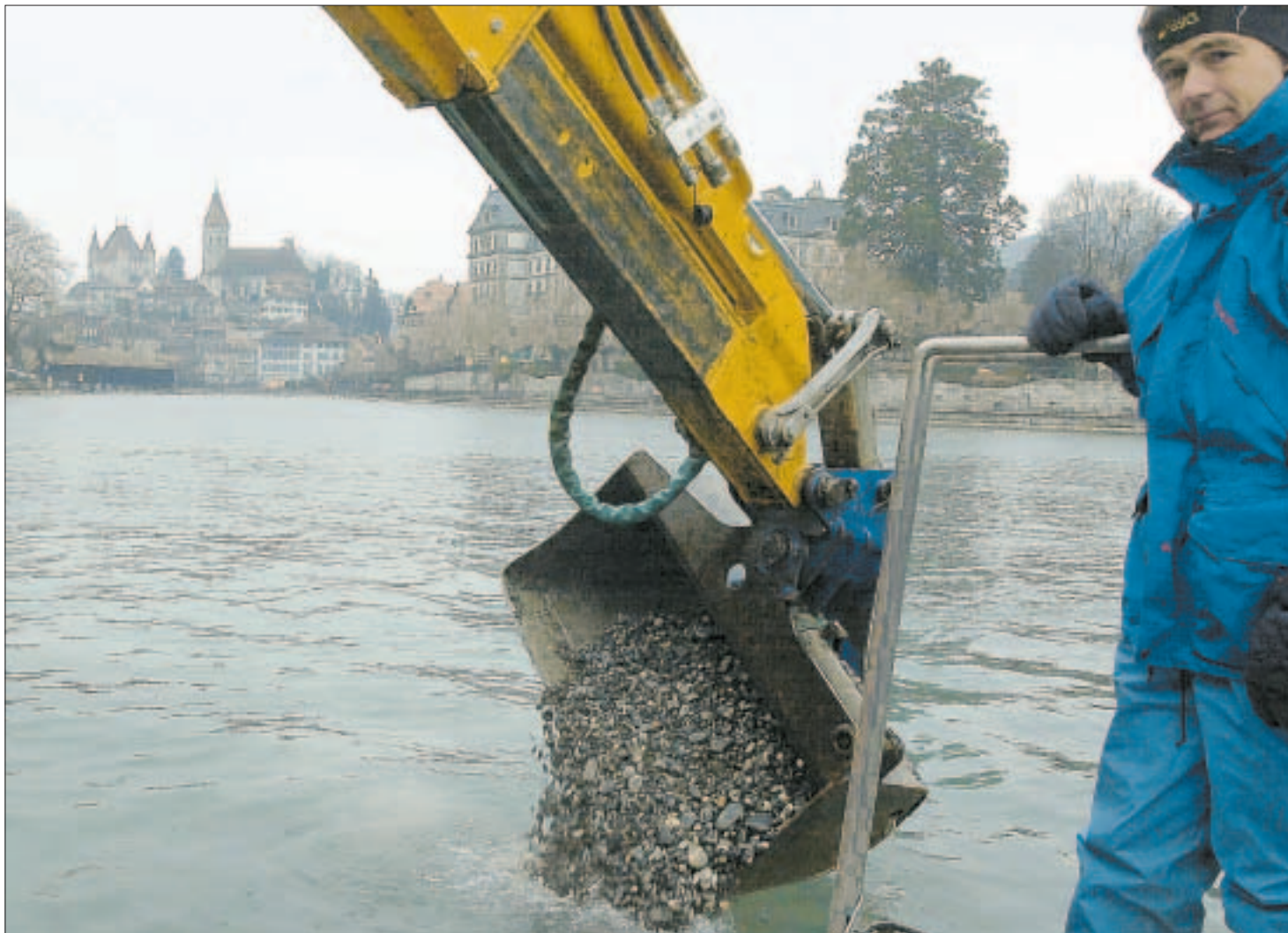
Mit diesem Bagger wird Flusskies im Aarebecken aufgeschüttet, um für die Äschen Ersatz-Laichplätze zu schaffen. Beobachtet werden die Arbeiten von Thomas Vuille vom kantonalen Fischereinspektorat.
