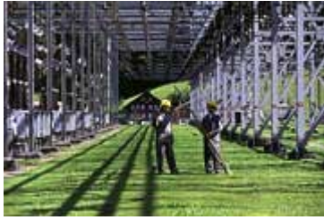
Kraftwerk Oberhasli-KWO in Innertkirchen: "Das Zeug ist turbiniert"
